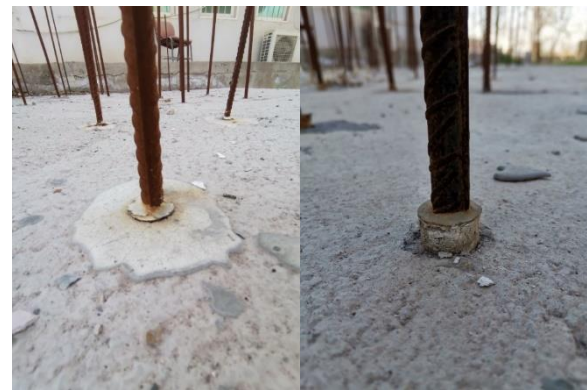
A. Grout B. Adhesive
